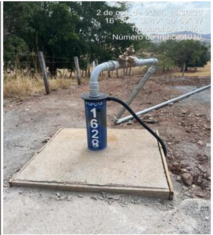
FOTO 4 - Poço 1628 interligado e operando.
