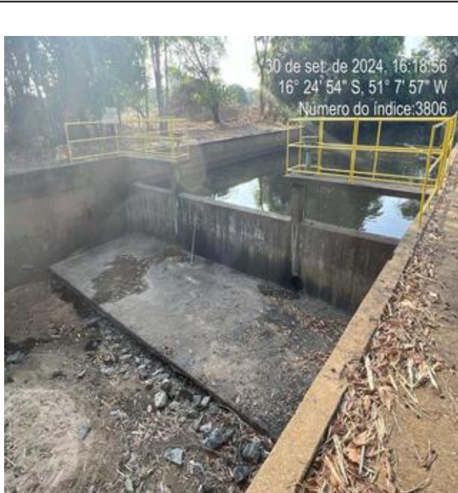
Foto 01 - Captação/Ribeirão Santo Antônio, sem água vertendo a jusante.
