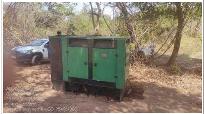
Foto 2 - Energização do Poço P 1014
