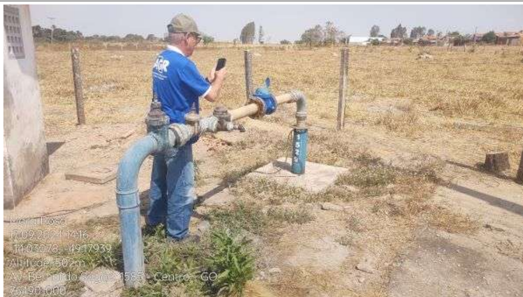
Foto 3 - Poço interligado. P 1529.
