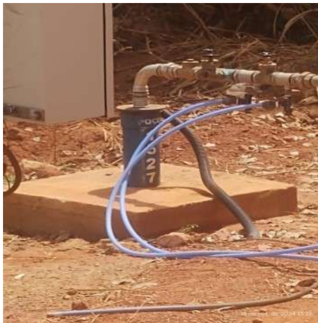
Foto 8 - Poço recente perfurado P 1527.
