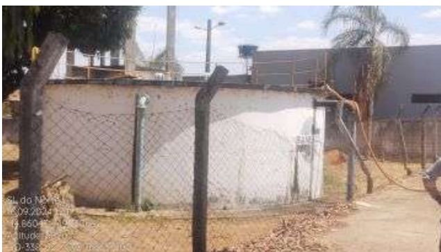
Foto 5 - Reservatório apoiado no Distrito.
