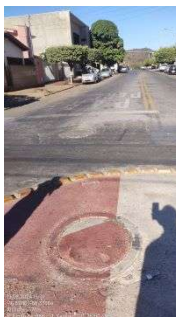
Foto 21 - Localização da adutora Santana- Aeroporto.
