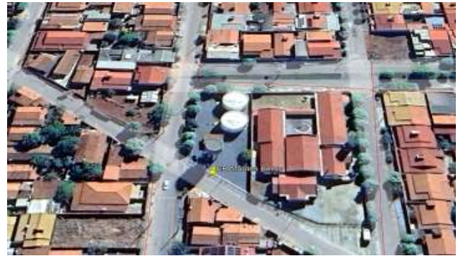
Foto 30 - Centro de Reservação Montes Belos, 2 RAP de 500 m 3 .
