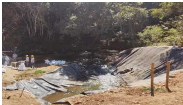
Foto 2 - Obras de construção de barragem de nível para captação de água - ribeirão Santa Rosa.
