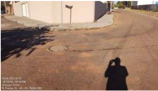
Foto 27 - Poço de Visita - Interceptor JK.
