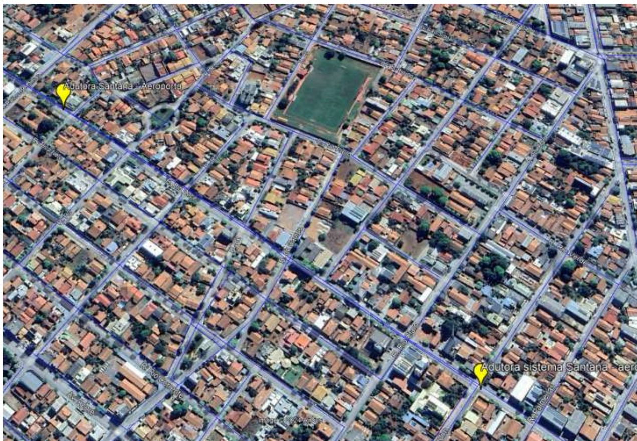
Foto 22 - Adutora Sistema Santana - Sistema Aeroporto (azul) e pontos vistoriados.
