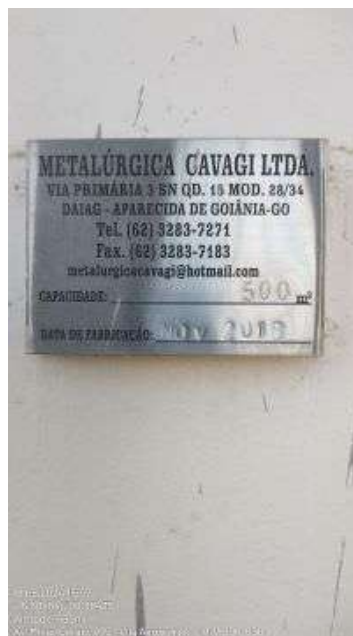
Foto 18 - Reservatório metálico 500 m³. CR Aeroporto.
