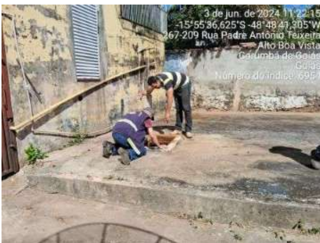
Figura 8 - Acesso ao interior do reservatório.
