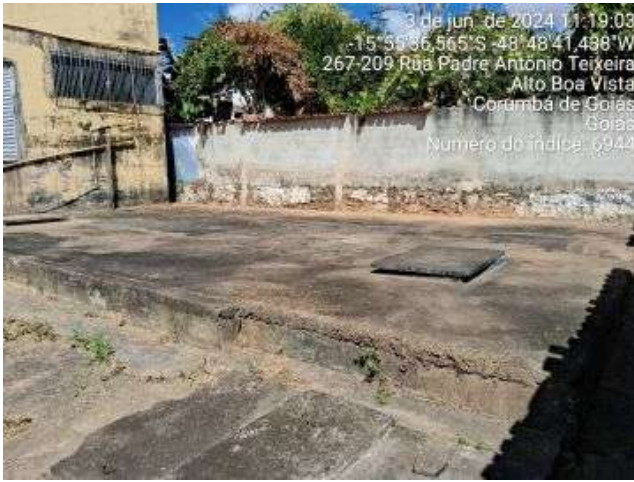
Figura 4 - Aspecto interno da área do reservatório.
