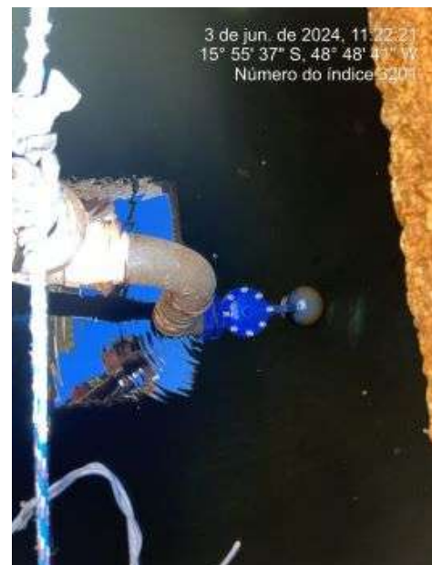
Figura 9 - Vista interna do reservatório (boia).
