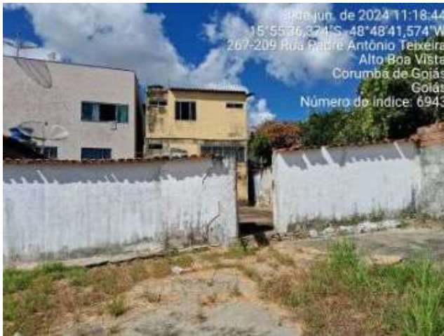
Figura 2 - Área externa do local do reservatório - rua 13, sem identificação da área como pertencente ao SAAE.
