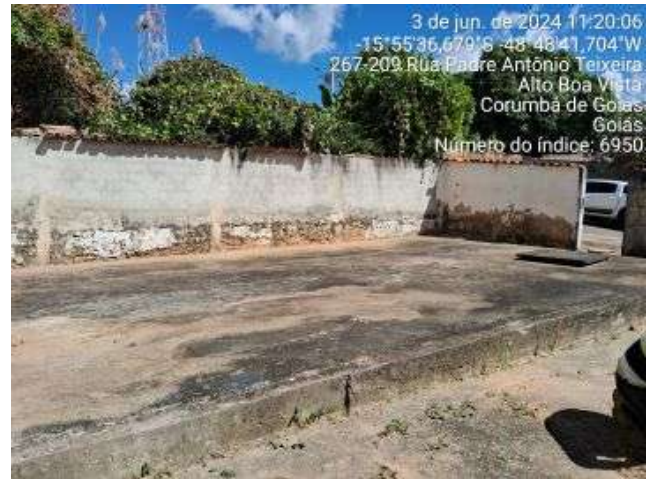
Figura 3 - Aspecto geral da parte superior do reservatório.
