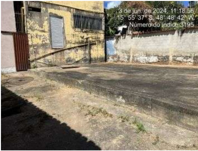
Figura 10 - Aspecto geral do reservatório e das residências limítrofes.
