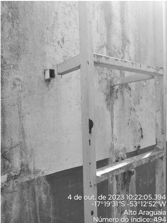
Foto 5 - Escada de acesso à galeria dos filtros danificada
