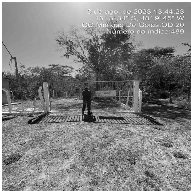
Foto 5 - Placa de identificação desgastada.
