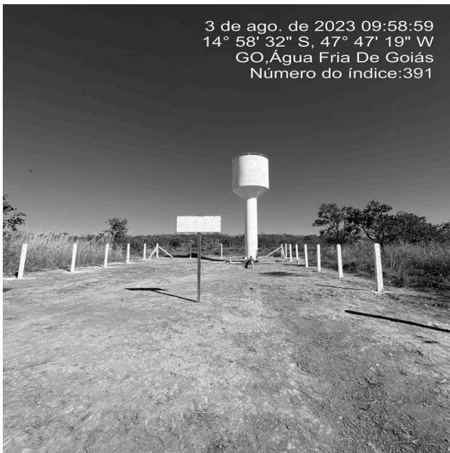
Foto 1 - Placa de identificação do REL deteriorada.
