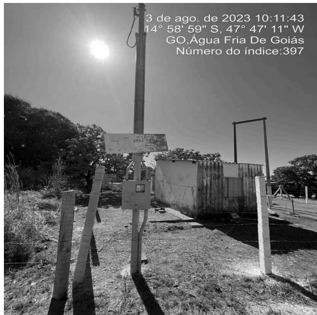
Foto 4 - Placa de identificação deteriorada.
