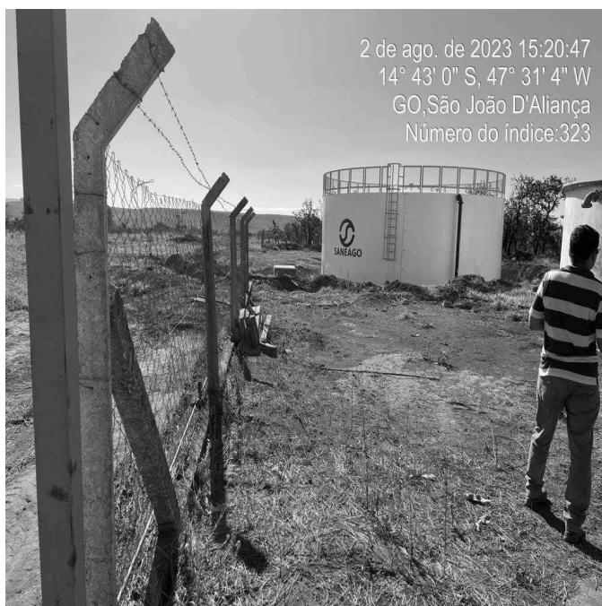
Foto 9 - C.R. St. Aeroporto RAP's 150, 300 e 500 m 3 com ausência de cercamento da área urbanizada.
