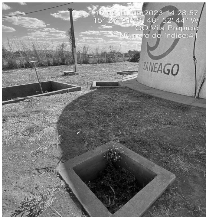
Foto 2 - C.R./Vila Propício com caixas de passagem sem grade de proteção ou tampa.
