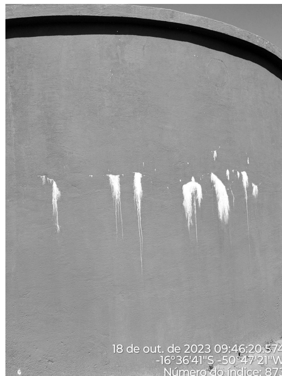
Foto 6 - Presença de infiltração e eflorescências no RAP do CR.
