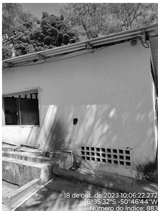
Foto 7 - Edificações da ETA com pintura desgastada.
