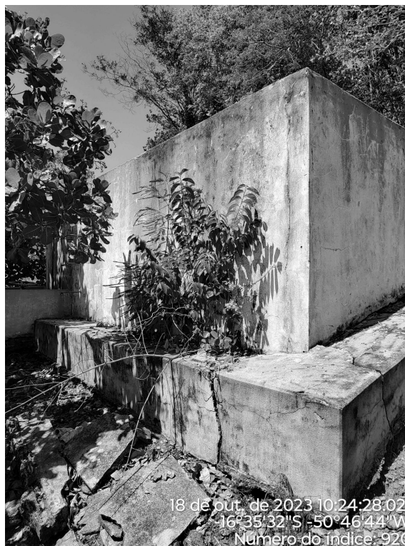
Foto 8 - Tanque de contato ETA com pintura desgastada.
