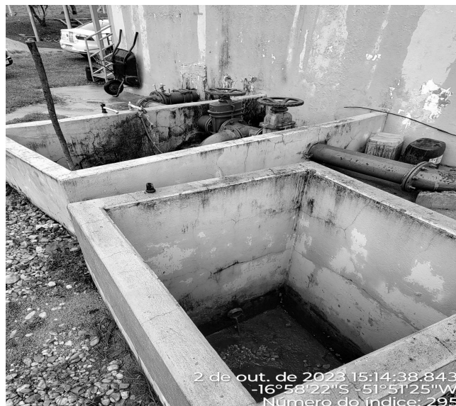
Foto 4 - Ausência de tampa ou grade de proteção nas caixas de passagem da ETA.
