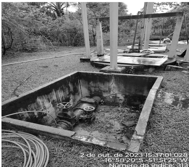
Foto 3 - Ausência de tampa ou grade de proteção nas caixas de passagem da captação.
