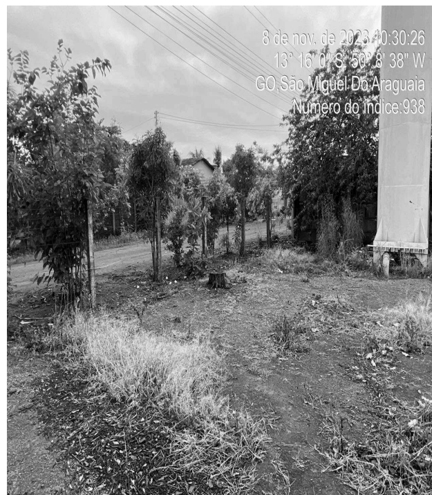
Foto 16 - RAP/REL Booster Vila Martins: cerca e muro de proteção da área danificados.
