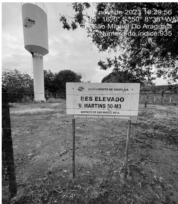
Foto 15 - RAP/REL Booster Vila Martins: pintura desgastada.
