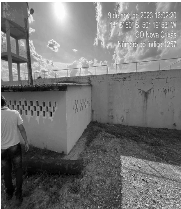
Foto 9 - RAP/ETA Semi enterrado 660 m 3 ,
