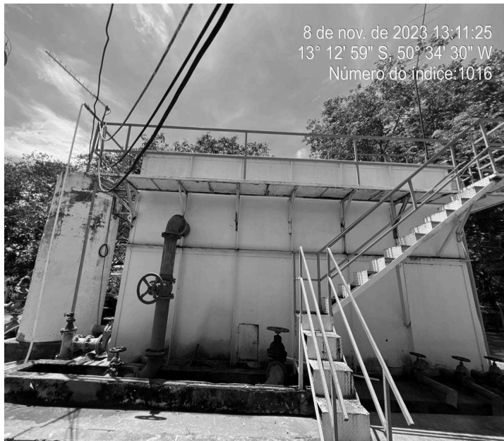
Foto 5 - ETA/Floculadores, Decantação e Filtração.
