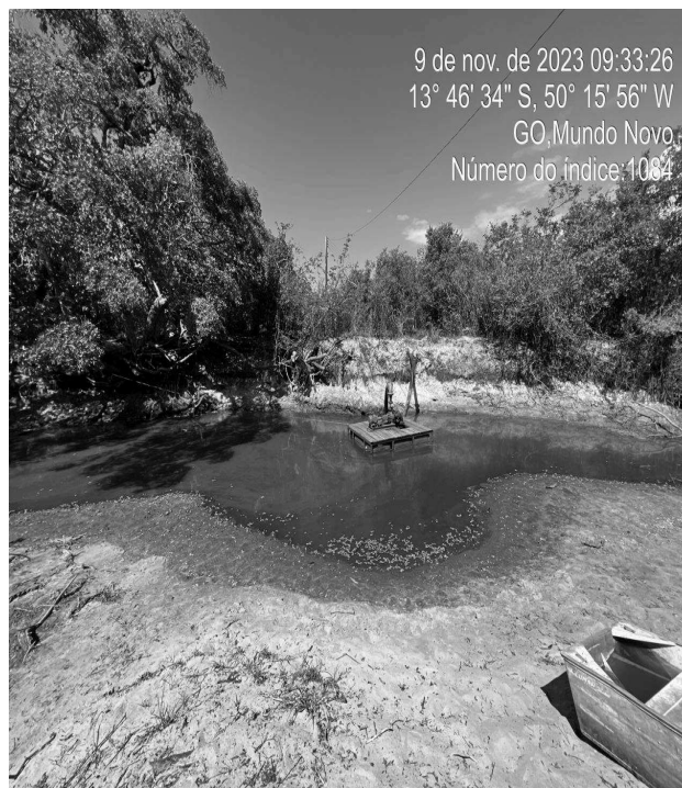
Foto 2 - Captação/EEAB, Rio Palmeiral: sem identificação.
