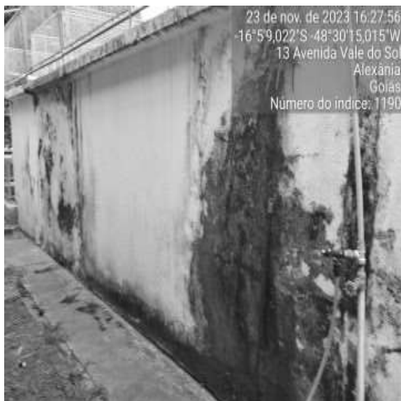
Foto 7 - ETA com infiltrações, rachaduras e pintura desgastada.
