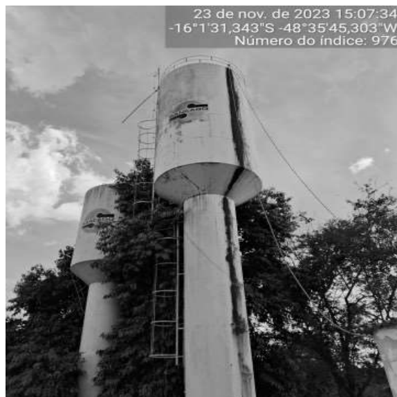
Foto 4 - Reservatório com corrosão e pintura danificada - REL Olhos D'Água.
