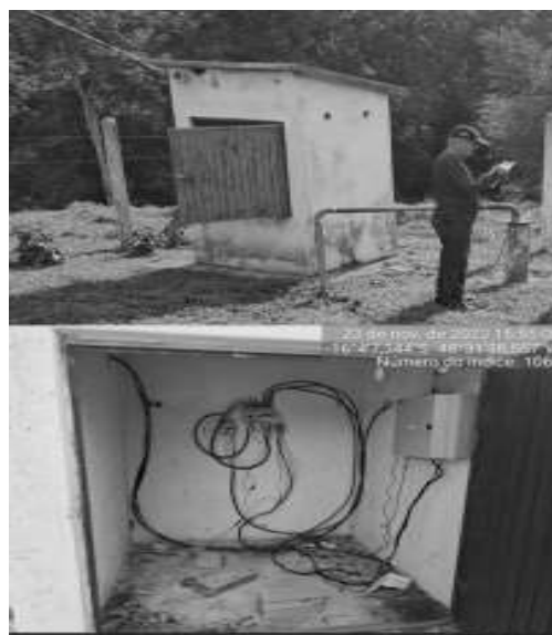
Foto 10 - Poço 08 com ausência de aviso de risco no quadro de comando.
