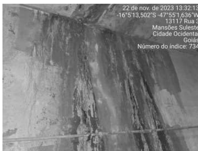
Foto 6 - Instalações da ETA com infiltração e trincas - vista interna.
