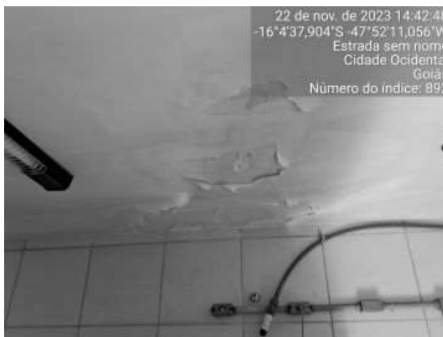
Foto 52 - Casa de cloração com perda de revestimento interno (Poço 1 - REL 50 m 3 - Sistema Mesquita II).
