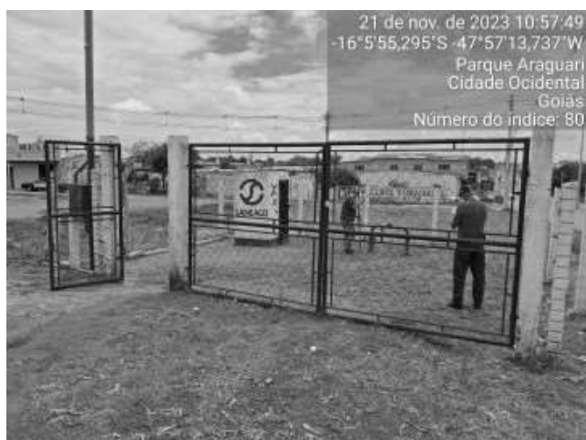
Foto 41 - Ausência de placa de identificação (Poço PSNI -01).
