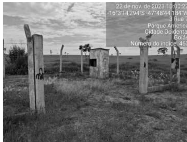
Foto 22 - Ausência de cerca de proteção da área (Poço 10 - Parque das Américas).
