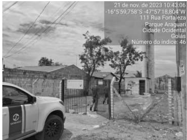
Foto 64 - REL com pintura danificada, ferrugem, vazamento e má condição de conservação da área (limpeza) - CR Araguari.
