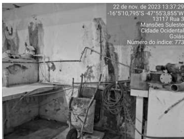
Foto 10 - Equipamentos de dosagem em mau estado de conservação (conexão do cloro gasoso) - ETA.
