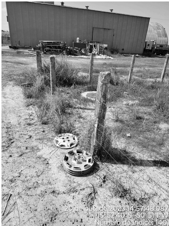
Foto 13 - Cerca danificada do REL Alto Boa Vista.
