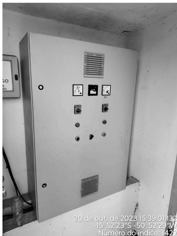
Foto 6 - Abrigo do quadro de comando do P15 (Associação) sem aviso de advertência.
