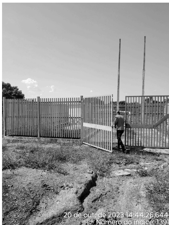
Foto 1 - P6 sem identificação.
