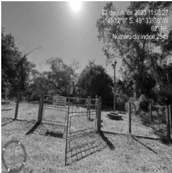
Foto 1 - Ausência de identificação da captação superficial no Rio dos Bois.
