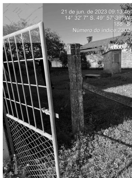
Foto 8 - Ausência de identificação no Booster Novo Horizonte.
