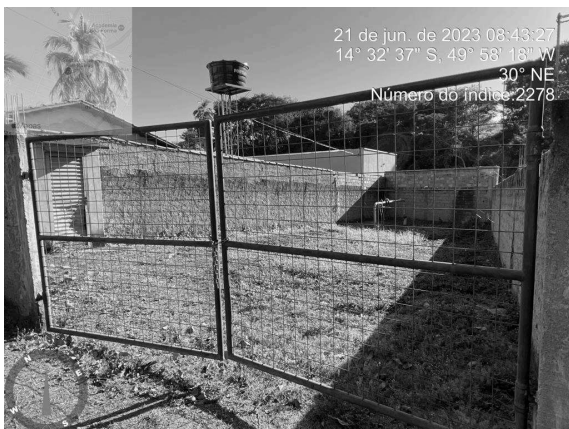
Foto 17 - Ausência de identificação no Poço 349.
