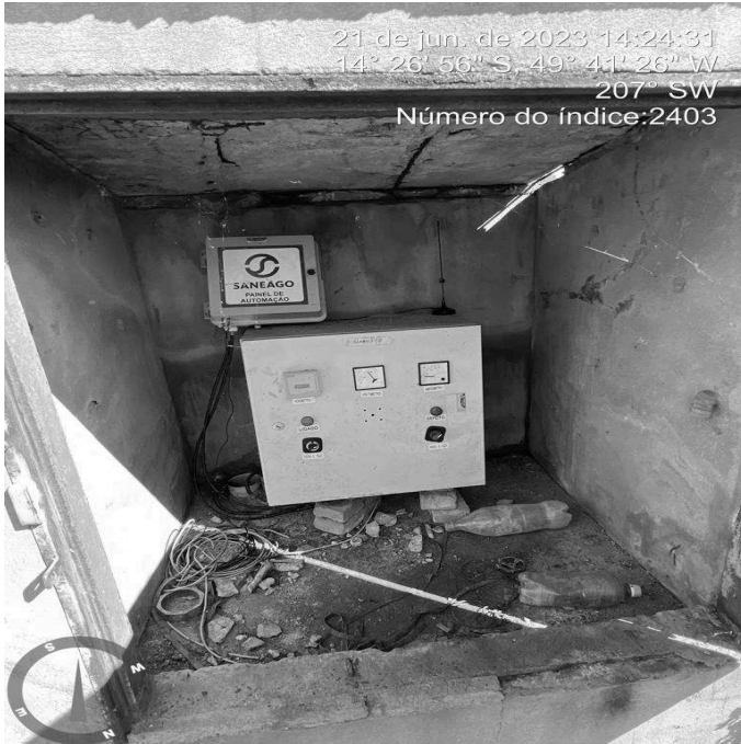
Foto 17 - Ausência de aviso de risco no quadro de comando do Poço 10.
