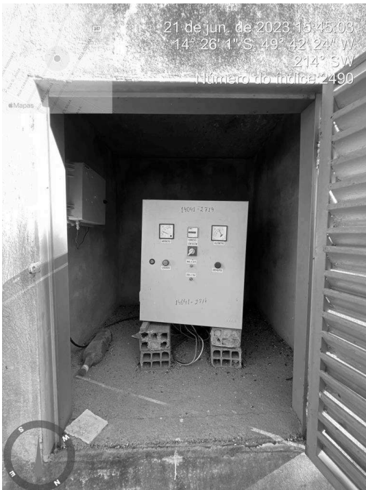
Foto 19 - Ausência de aviso de risco no quadro de comando do poço 13.
