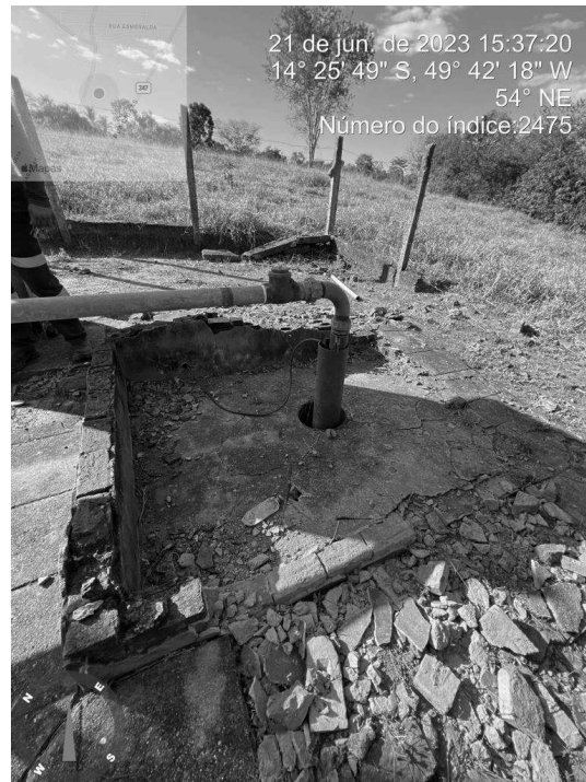
Foto 20 - Ausência de tampa de proteção no Poço 3.
