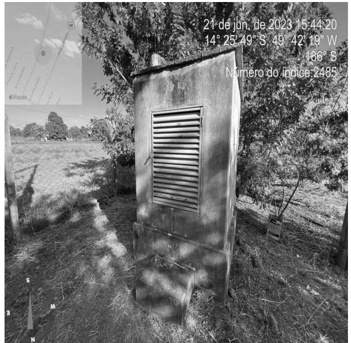
Foto 18 - Ausência de aviso de risco no quadro de comando do poço 13
