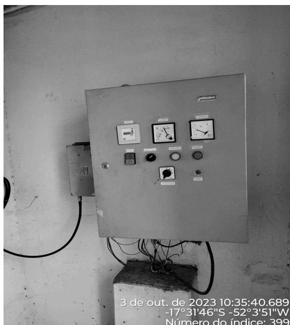
Foto 3 - Abrigo do quadro de comando do P4 com pintura desgastada.
