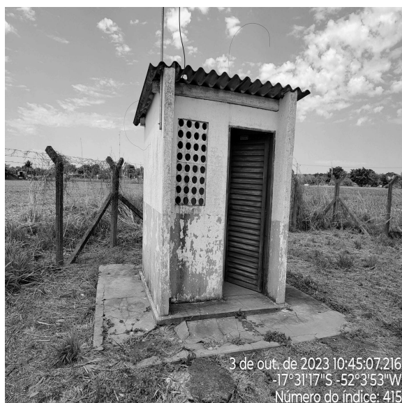
Foto 3 - Abrigo do quadro de comando do P4 com pintura desgastada.
