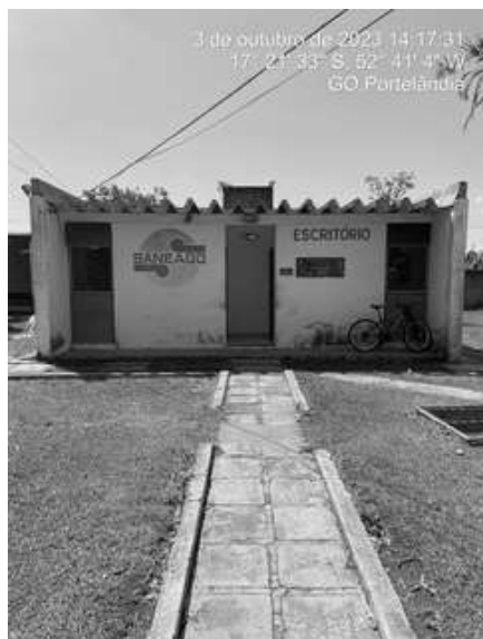
Foto 1 - Edificações do escritório comercial do distrito com pintura desgastada.
