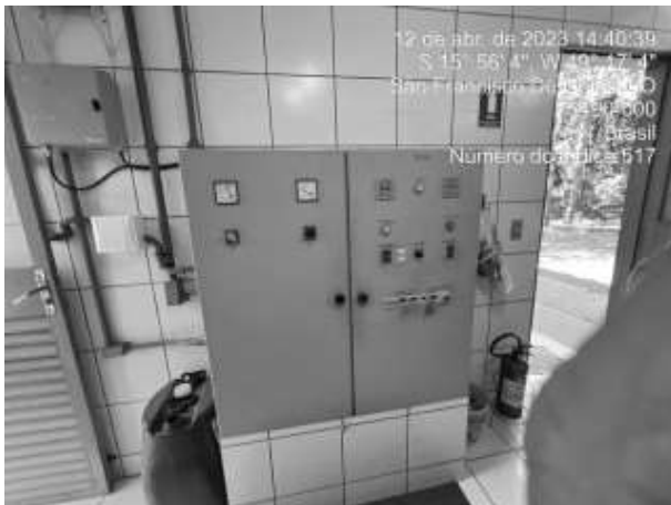
Foto 1 - Quadro de comando da EEAB e EEAT da ETA sem aviso de risco.
