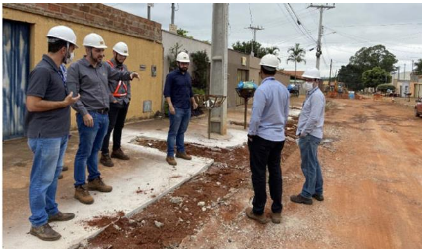
Figura 6. Gerente de Saneamento Básico da AGR, Eduardo Henrique da Cunha, vistoria obras da BRK em Trindade
