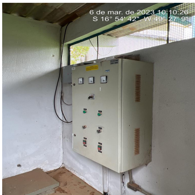
Foto 15- Poço com área de risco sem aviso de advertência.
