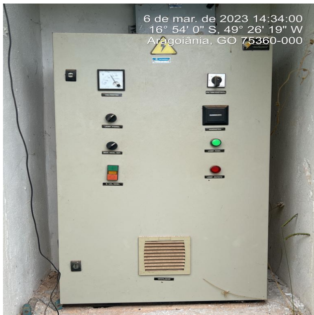
Foto 12 - Poço com área de risco sem aviso de advertência.
