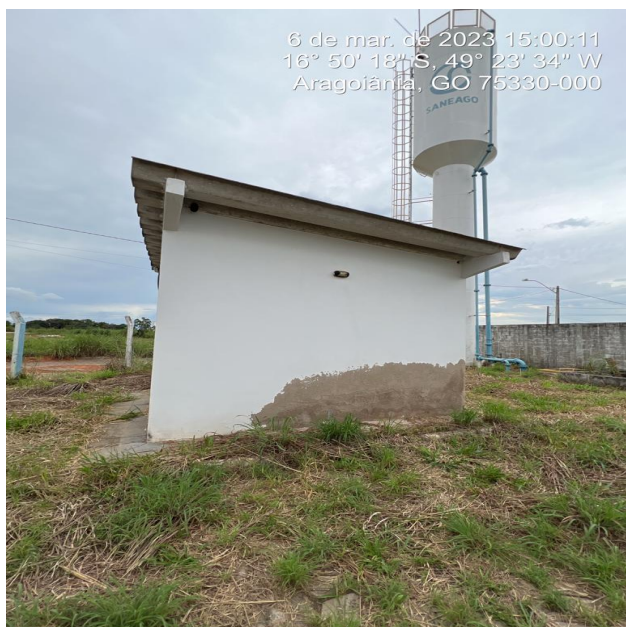
Foto 17- Centro de Reserva Portal Dourados com casa de química com perda de revestimento.
