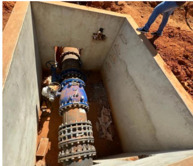
Figura 8 - Obras de interligação ao Sistema Produtor Corumbá. Não concluída na data da vistoria.
