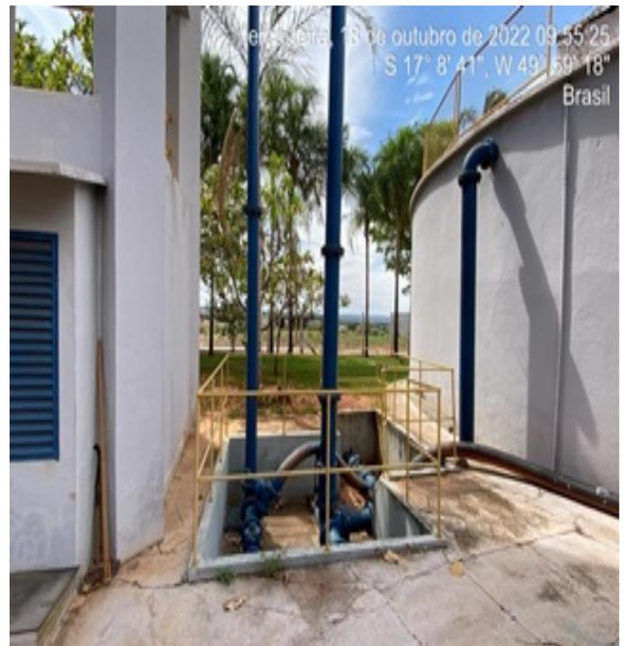
**Foto 14** - EEAT/CR com grade de proteção instalada.
