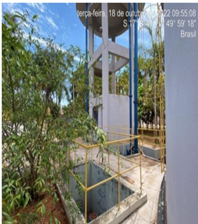
**Foto 5** - CR/REL, caixa de passagem II com grade de proteção instalada.
