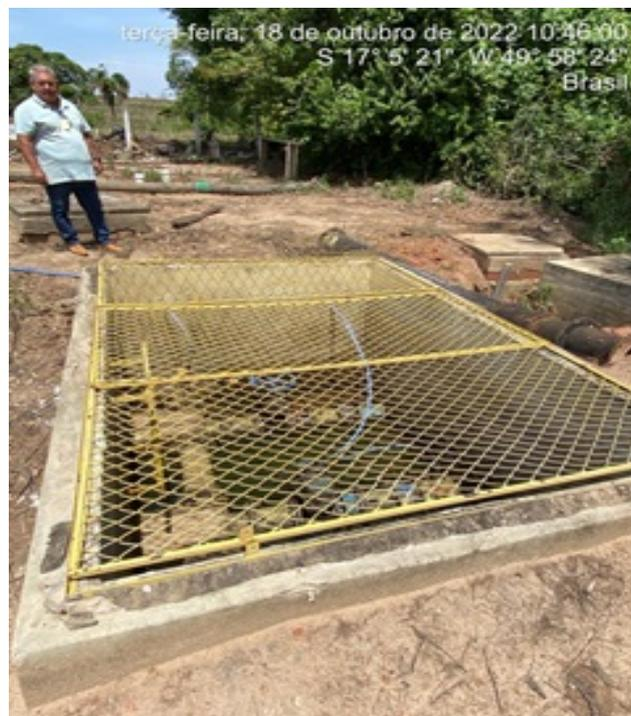
**Foto 8** - Captação/EEAB, caixa de passagem com grade proteção instalada.
