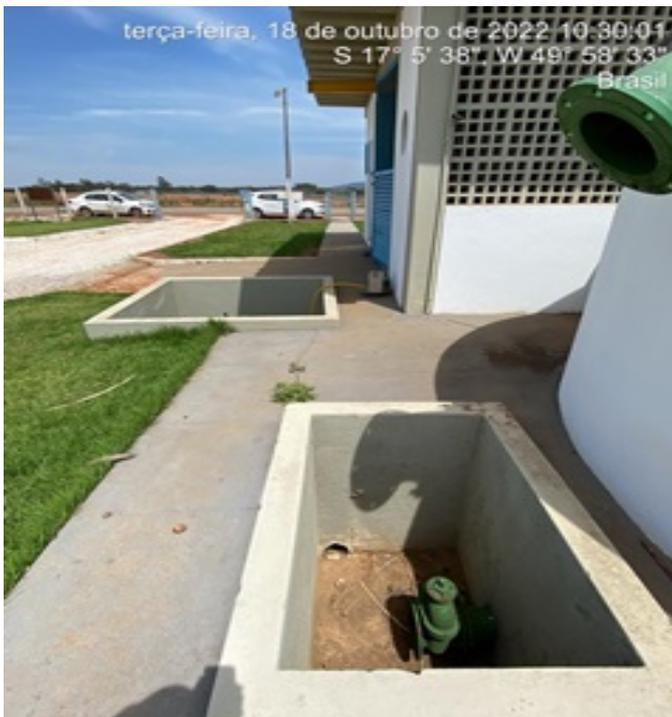
**Foto 13** - ETA nova com caixas de passagem sem tampa ou grade de proteção.
