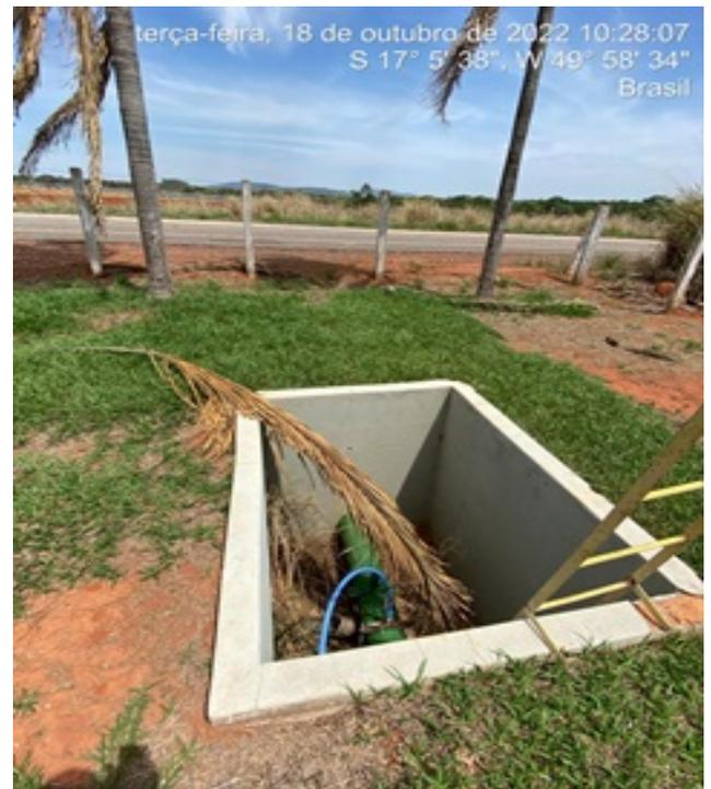
**Foto 12** - ETA nova com caixas de passagem sem tampa ou grade de proteção.
