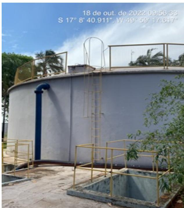
**Foto 3** - CR/RAP, com guarda-corpos instalados na escada e topo.
