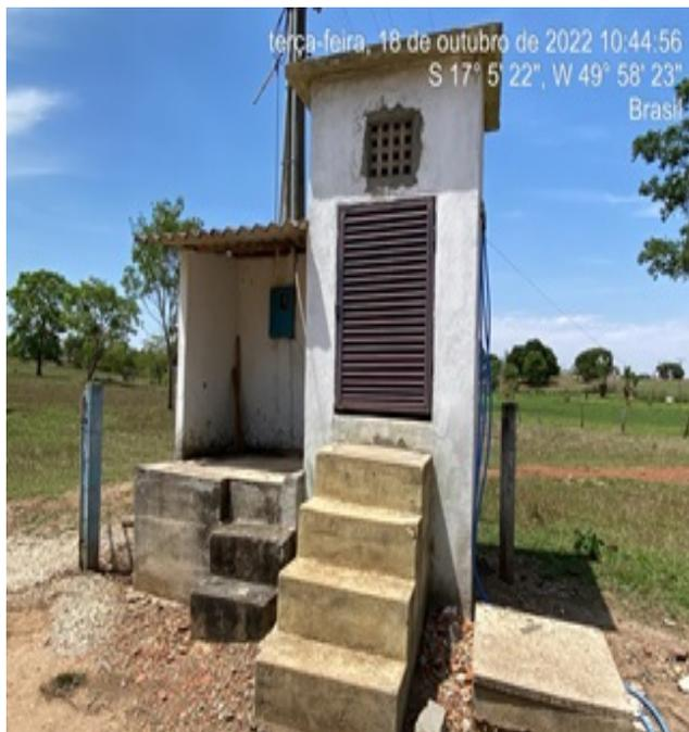
**Foto 7** - Captação/EEAB com quadro de comando elevado devido inundação da área.
