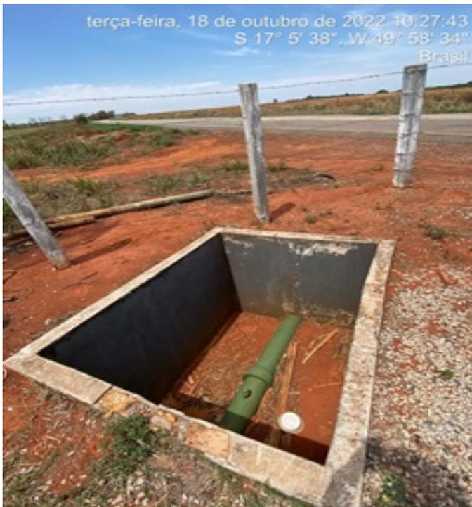
**Foto 11** - ETA nova com caixas de passagem sem tampa ou grade de proteção.
