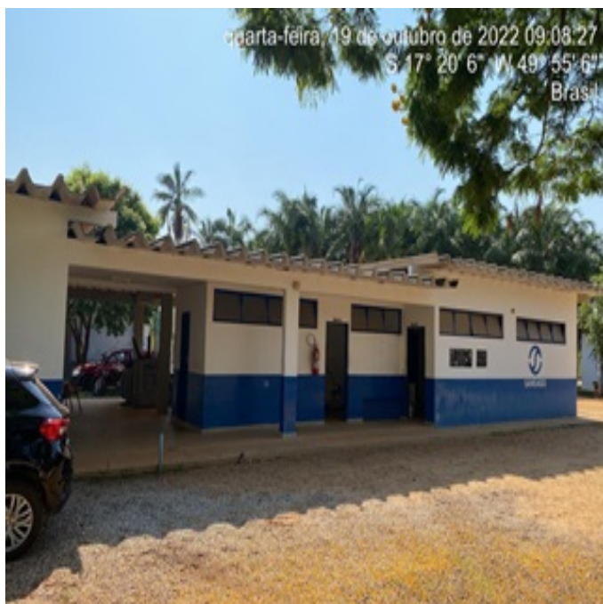
Foto 1 - ETA com pintura recuperada das unidades do SAA.
