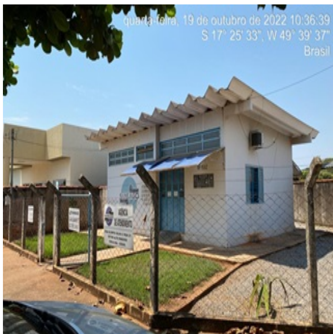
Foto 3 - ETA com pintura recuperada das unidades do SAA.
