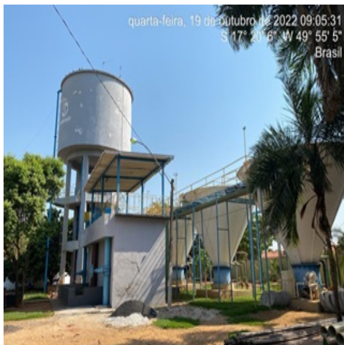
Foto 2 - ETA com pintura recuperada das unidades do SAA.
