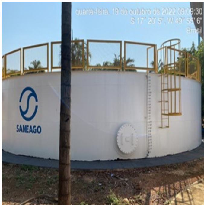
Foto 7 - ETA/RAP metálico com guarda-corpos escada e topo instalados.
