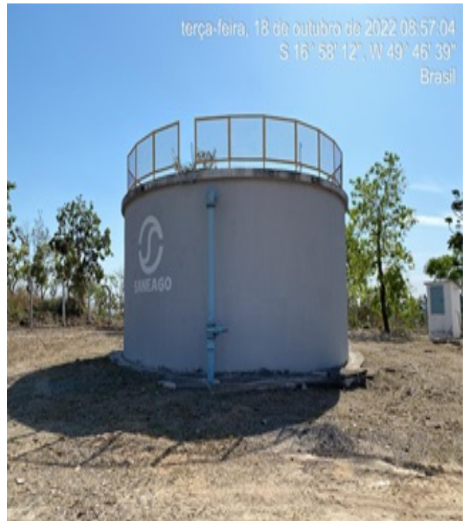
Foto 6 - C.R. RAP II com pintura recuperada.
