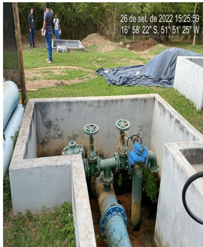
**Foto 2** - ETA com caixas de registros sem tampa de proteção.
