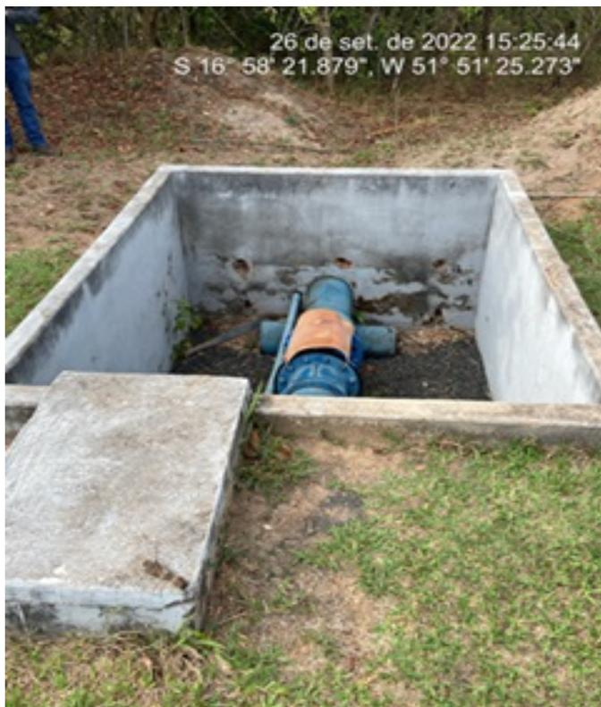
**Foto 1** - ETA com caixa de passagem sem tampa ou grade de proteção.
