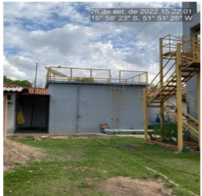
**Foto 2** - ETA com poço de sucção pintado e escada com guarda-corpo instalado.
