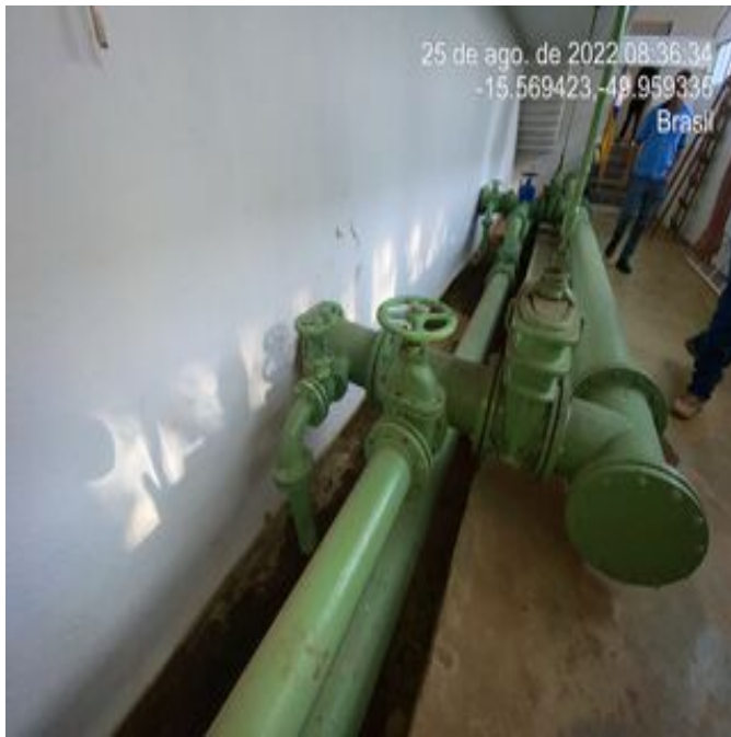
Foto 1 - Galeria dos filtros com ausência de vazamento e perda de revestimento.
