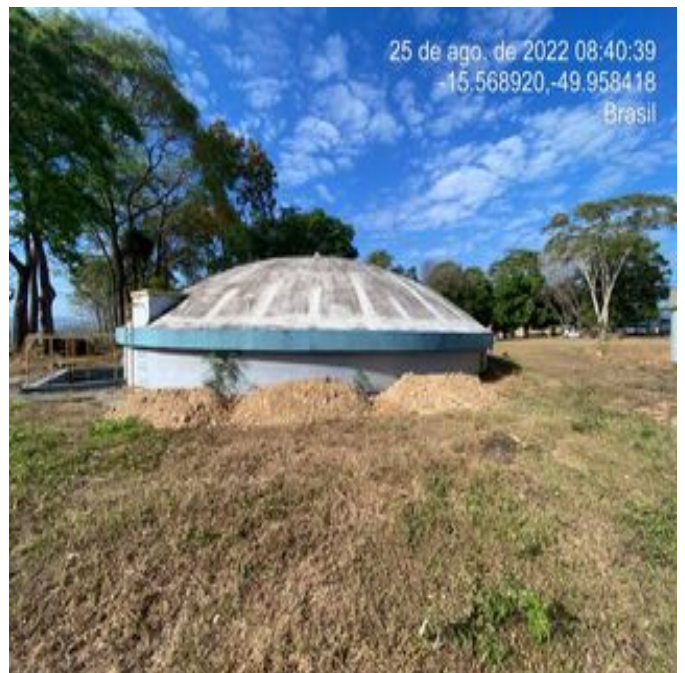
Foto 4 - Reservatório Semi-enterrado 1 com pintura.
