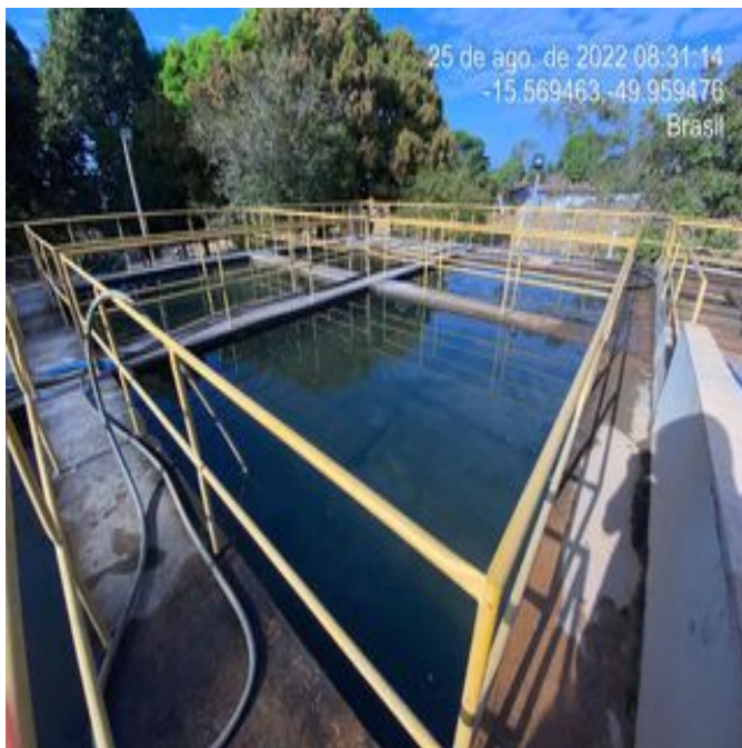
Foto 3 - Guarda-corpos com ausência de ferrugens
