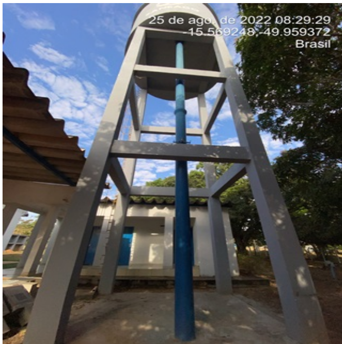
Foto 5 - ETA/REL de lavagem de filtros com pintura recuperada.
