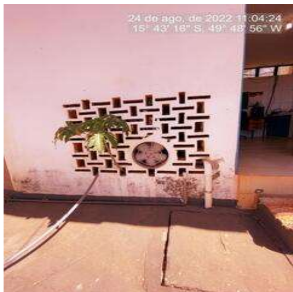
Foto 3 - Sala de química da ETA com exaustor funcionando.
