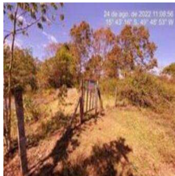
Foto 4 - Captação com cerca de proteção recuperada.
