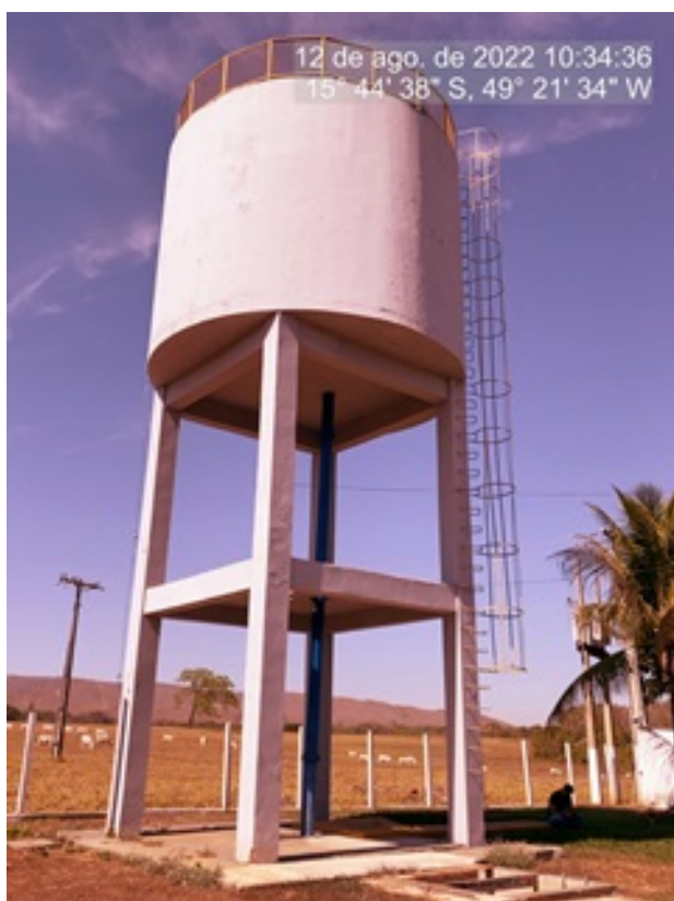
Foto 3 - REL da ETA com pintura recuperada.
