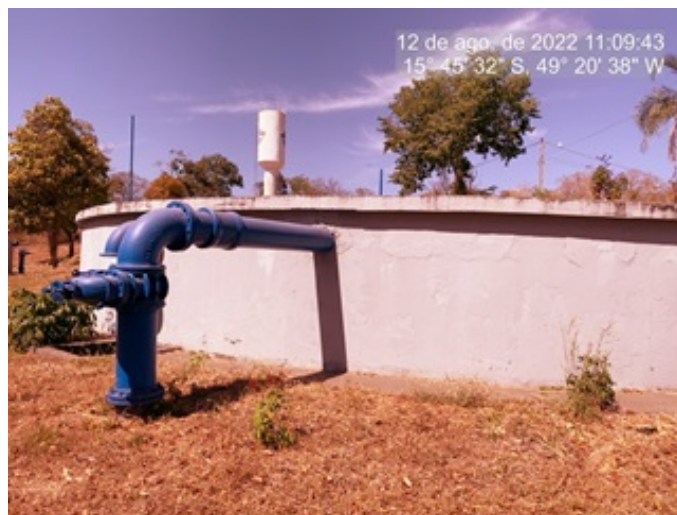
Foto 6 - Ferragem da borda do RAP R2 recuperada.
