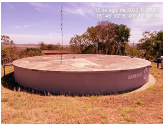
Foto 5 - Ferragem da borda do RAP R1 recuperada
