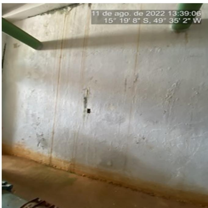
**Foto 3** - Novas Infiltrações detectadas na ETA Ceres.
