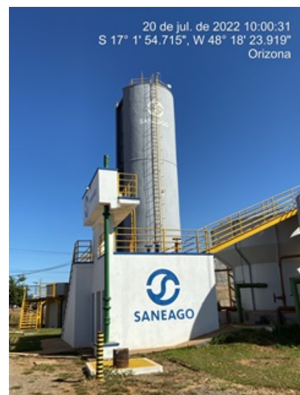
Foto 2 - Parede externa dos filtros com infiltrações corrigidas.
