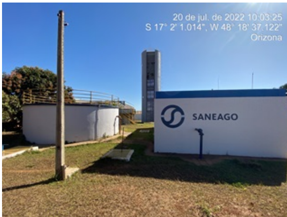
Foto 7 - RAP da ETA com pintura recuperada.
