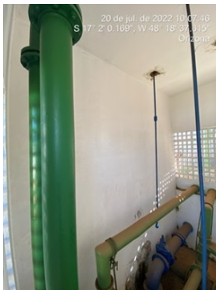
Foto 1 - Galeria dos filtros com infiltrações corrigidas.
