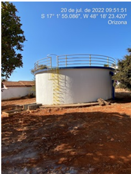
Foto 5 - RAP do Distrito com guarda corpo instalado.
