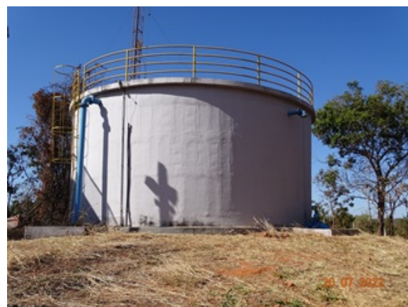
Foto 4 - RAP Concreto com guarda corpo instalado.
