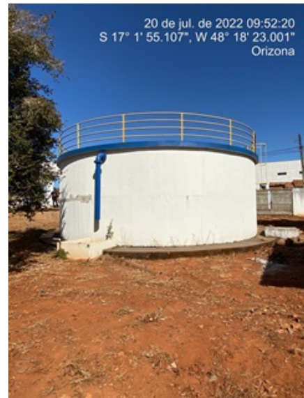
Foto 6 - RAP do Distrito com infiltrações corrigidas.
