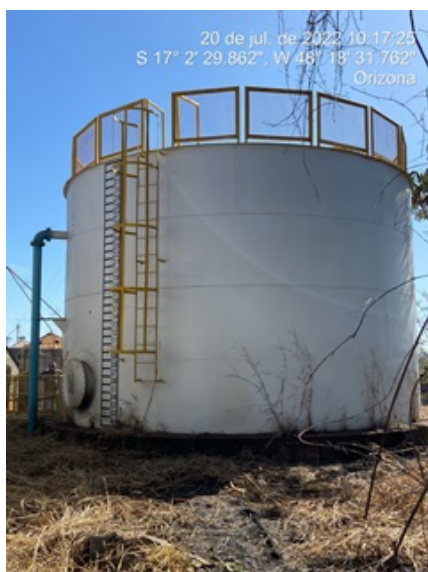
Foto 3 - REL Metálico com guarda corpo instalado.
