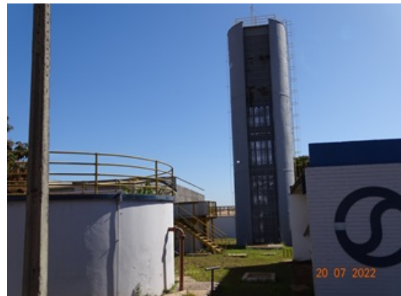
Foto 8 - REL da ETA com pintura recuperada.
