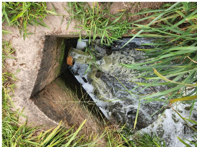
**Foto 8** - Efluente tratado sendo despejada no corpo receptor (Ribeirão Arrojado).
