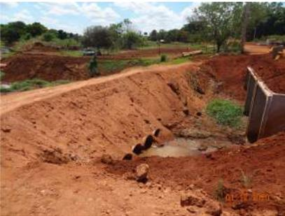
**Foto 3** - Manilhas de concreto na base do aterro para controle do fluxo de água na saída dos bueiros.
