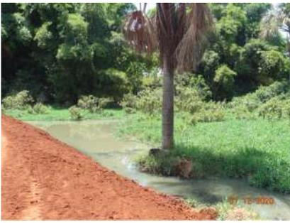
**Foto 9** - Água do córrego Mangueira barrada e sendo direcionada de volta ao leito original.
