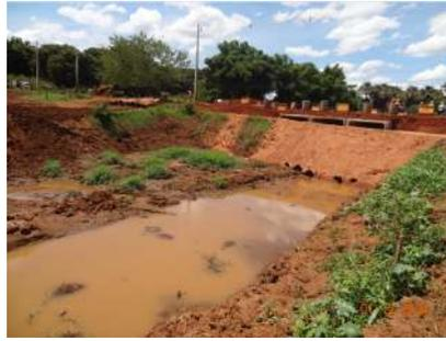
**Foto 2** - Aterro de proteção construído pela BRK.
