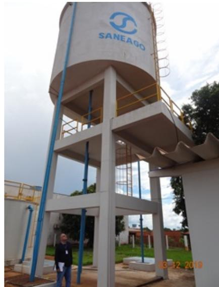
**Foto 2** - REL com guarda-corpos instalado na escada de acesso.
