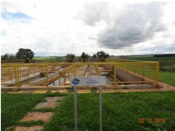
**Foto 3** - ETE/reatores anaeróbicos C com guarda-corpos instalados.
