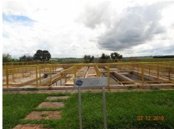
**Foto 2** - ETE/reatores anaeróbicos B com guarda-corpos instalados.
