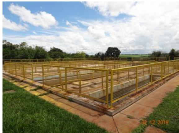
**Foto 4** - ETE/vista panorâmica dos reatores anaeróbicos com guarda-corpos instalados.
