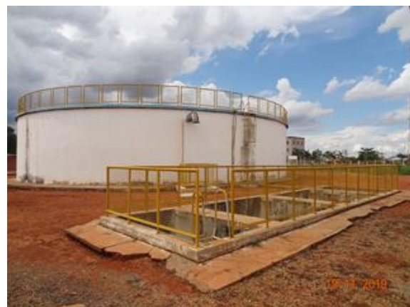
Foto 2 - RAP Itapuã II com guarda-corpos na escada, cobertura e área dos registros de saída do
