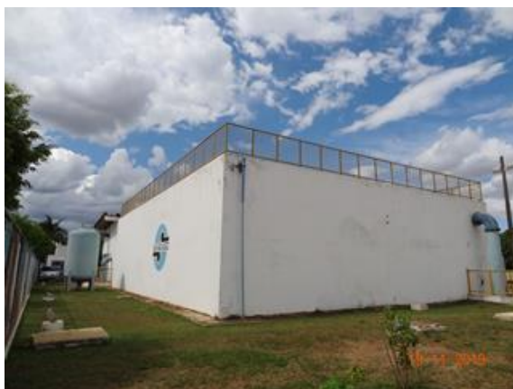
Foto 1 - RAP semienterrado do escritório com guarda-corpos na cobertura.
