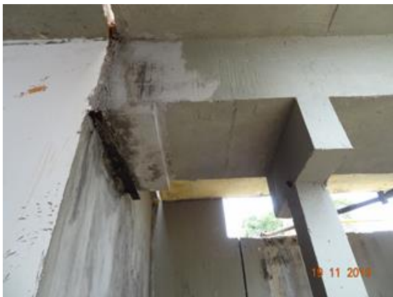
Foto 1 - Vazamento na calha parshall recuperado.
