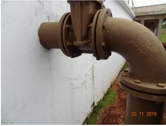
Foto 1 - infiltração recuperada na ETA
