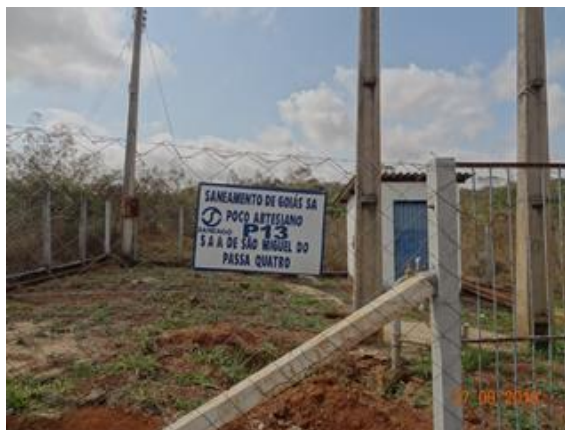
Foto 4 - Poço 13 com cerca recuperada.
