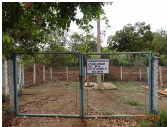
Foto 6 - Poço 04 com placa de identificação recuperada.
