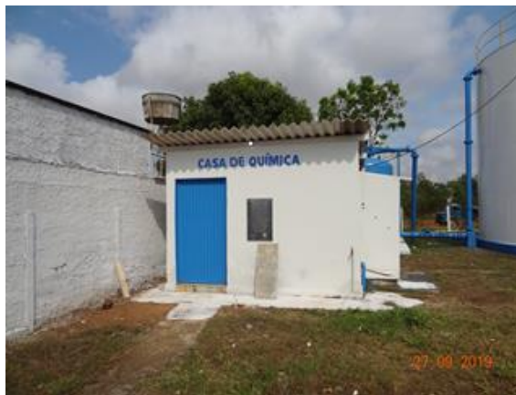
Foto 2 - Casa de Química do RAP com ausência de perda de revestimento.
