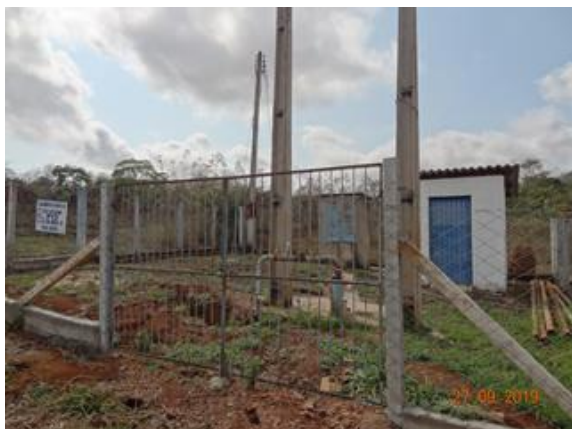
Foto 5 - Poço 13 com cerca recuperada.
