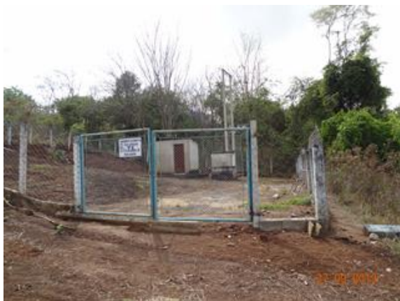
Foto 3 - Poço 02 com cerca recuperada.
