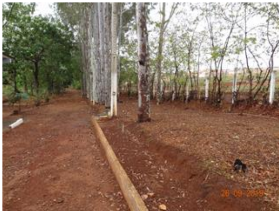
Foto 3 - ETE sem fiação elétrica exposta no jardim.
