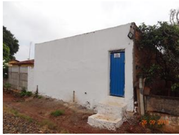
Foto 2 - EEE do Presídio com revestimento e pintura.
