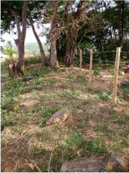
Foto 5 - Cerca de proteção da área da ETA refeita.
